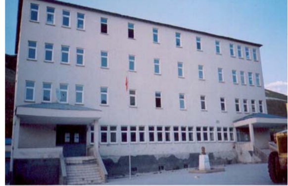
Şekil 7 - Güçlendirilen pansiyon binası
